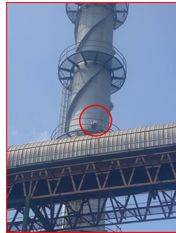
ภาพที่ 2.2-2 ระบบตรวจวัด Oxygen Analyzer Sensor
