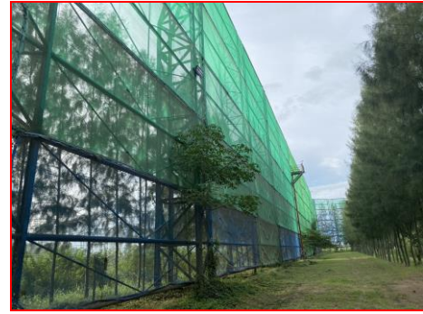
ภาพที่ 2.2-11 โครงสร้างเหล็กติดตาข่ายล้อมรอบพื้นที่ลานกองขาน้อย
