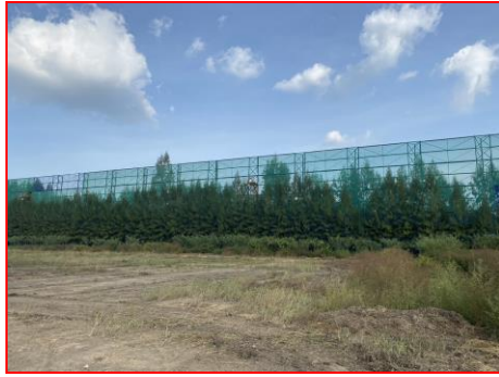
ภาพที่ 2.2-11 โครงสร้างเหล็กติดตาข่ายล้อมรอบพื้นที่ลานกองขาน้อย
