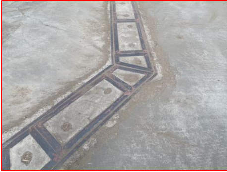
ภาพที่ 2.2-26 รางระบายน้ำที่ไปยังบ่อบำบัดของโรงงานน้ำตาล
